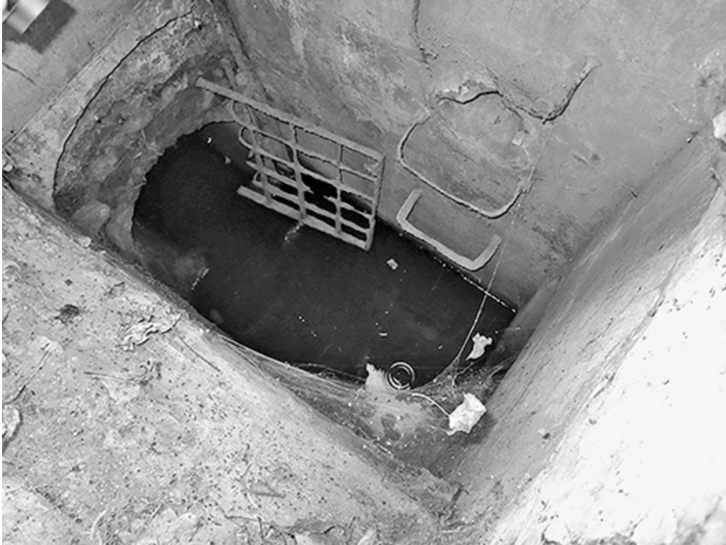
Sewers of the main camp. Courtesy of Katarzyna Chiżyńska.
